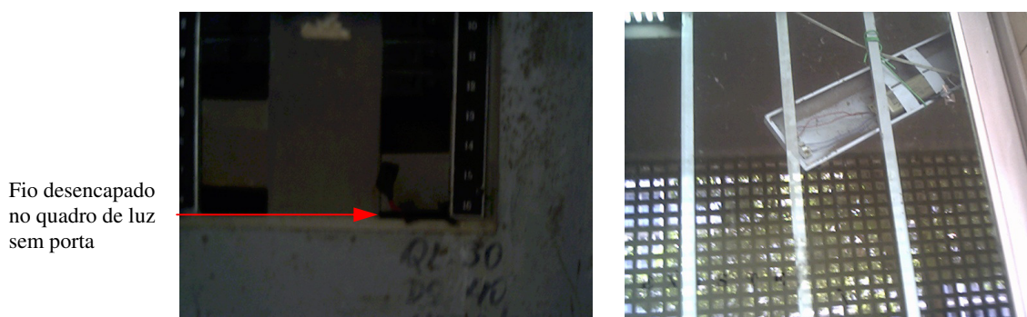
Figura 4.26 Fiação elétrica exposta, quadro de luz sem porta, luminária pendurada. Autor: Espírito Santo (2004)
