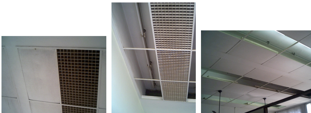
Figura 4.21 Alguns tipos de forros utilizados nos rebaixos de teto. Autor: Espírito Santo (2004)
