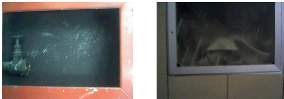
Figura 4.30 Instalações de combate em estado precário. Autor: Espirito Santo (2004)
