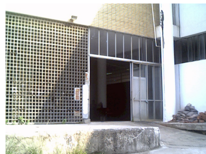
Figura 4.36 Acesso 3 – bloco D.
