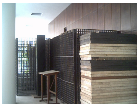
Figura 4.31 Classe A, atrás do bloco de elevadores. Autor: Espirito Santo (2004)
