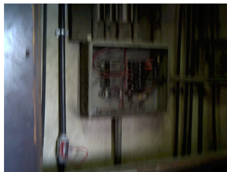
Figura 4.28 Vista interna do shaft . Autor: Espírito Santo (2004).
