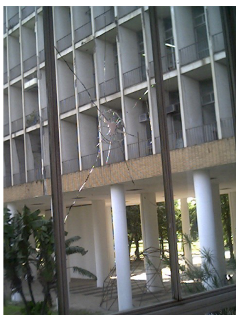
Figura 4.15 Base em Pilotis – bloco A. Fonte: Espírito Santo (2004)
