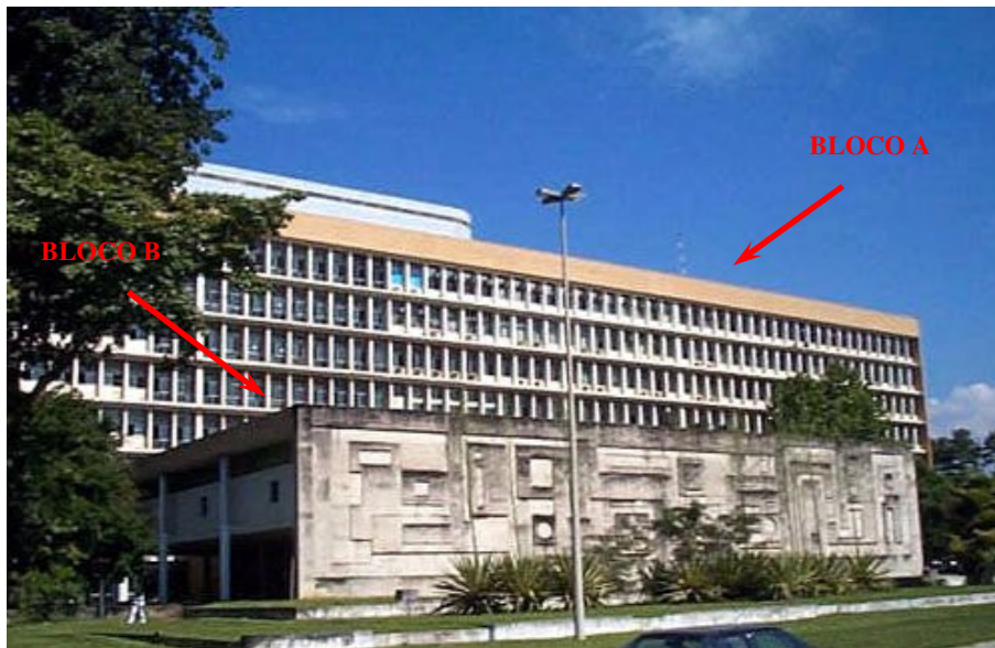
Figura 4.9 Fachada NO dos blocos A e B – FAU/UFRJ. Fonte: Espírito Santo (2003)
