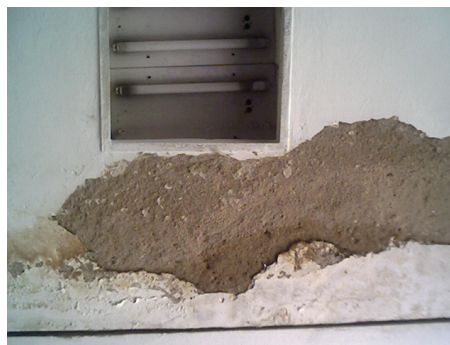
'Teto da sala de material de construção'.
