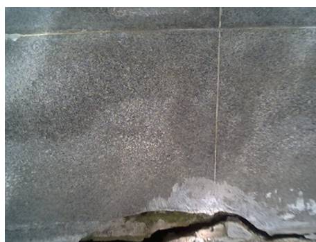
Figura 4.19 Trecho da fachada em pedra, com rachadura superficial. Autor: Espírito Santo (2004)
