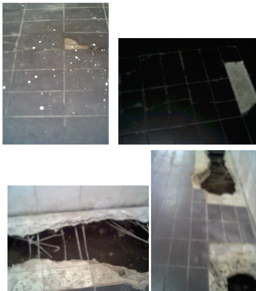
Figura 4.22 Piso deformado, cerâmica faltando e buracos na laje do piso. Autor: Espírito Santo (2004)
