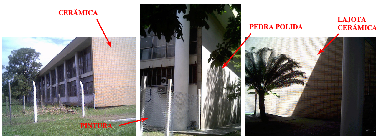
Figura 4.18 Revestimento das fachadas. Autor: Espírito Santo (2004)
