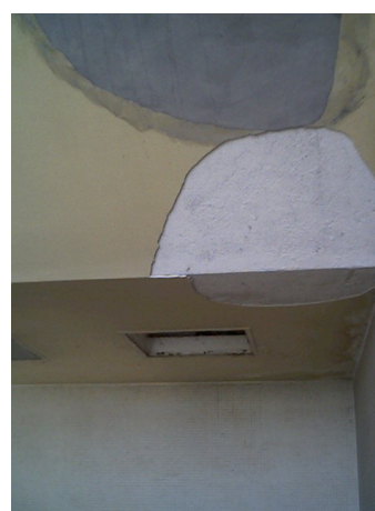
'Teto da caixa de escada'.
